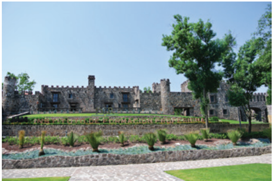
Instalaciones del Instituto de Formación Ministerial, Policial y Pericial de la PGR (IFMPP), también conocido como La Muralla, ubicado en el municipio de San Juan del Río, Querétaro.
